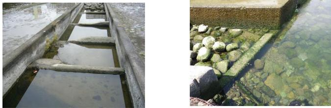
図 4-2 渇水時の魚道（左：魚道内、右：魚道下端）
