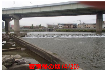
図 2-1 豪雨後の可動堰の状況（開放により魚道への流入がなくなる）
