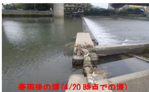
図 2-1 豪雨後の可動堰の状況（開放により魚道への流入がなくなる）
