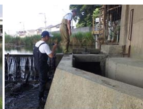
降下用魚道（左岸側）
