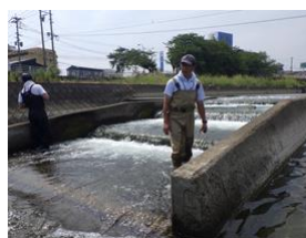
新池井堰の魚道
