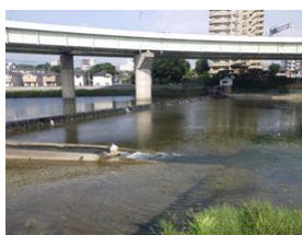
紫川井堰（右岸側）
